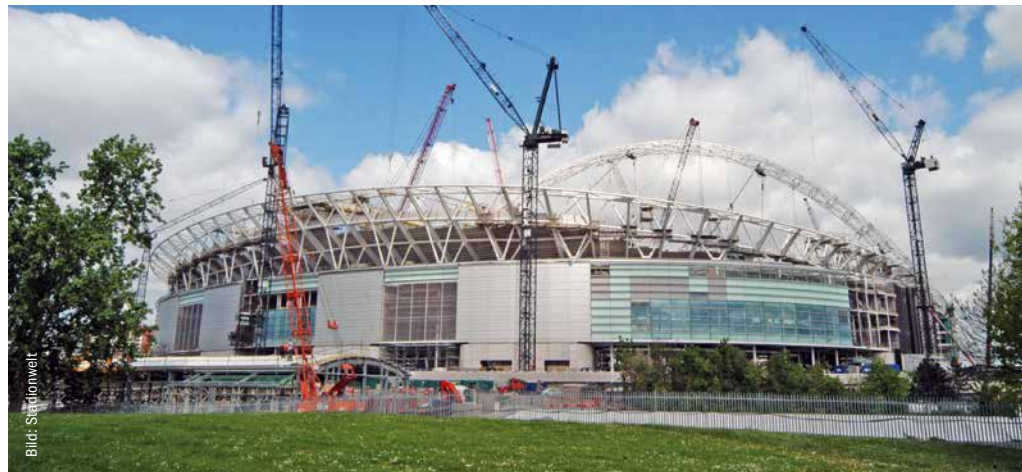
Schon in der Planung und Bau sollten Nachhaltigkeitsaspekte berücksichtigt werden.
