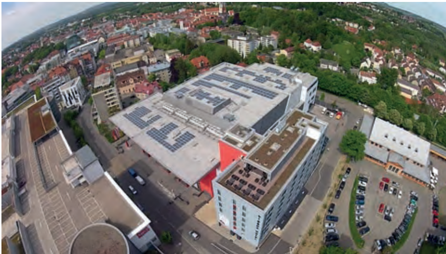
| Die bigBIOX Allgäu nutzt seit 2011 ausschließlich Ökostrom. Und seit Juni 2014 ist auf dem Dach der Halle sogar eine eigene Photovoltaikanlage in Betrieb | Foto: FH Promotions
